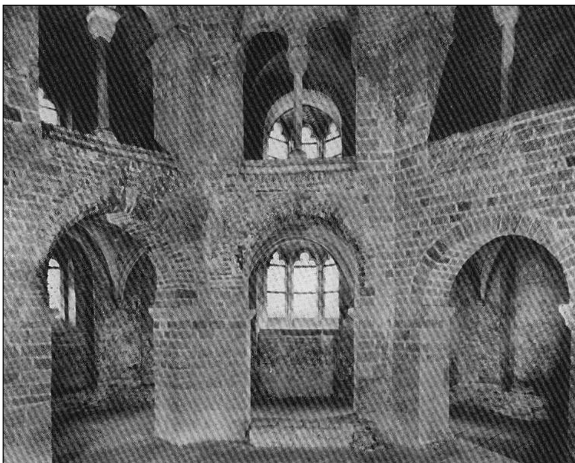
NIMEGUE. Intérieur de la Chapelle Saint-Nicolas (XI e siècle) après la dernière restauration de 1953-1956. Il commence à devenir tragi-comique que l'Université de Nimègue continue à présenter cette chapelle, qui fut la première église paroissiale de la ville comme chapelle carolingienne ou palatine.
