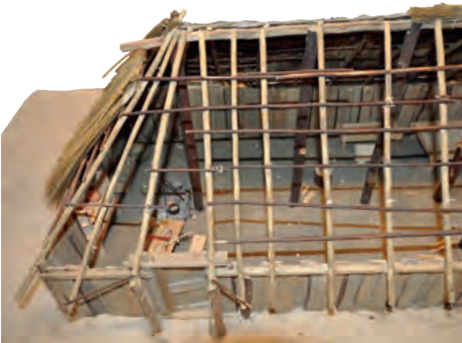
fig. 5.15 Impressie van het woongedeelte (rechts) en het stalgedeelte (boven) van het tweebeukige woonstalhuis 3 uit Bloemendaal-Groot Olmen. De kasporen zijn tegen de nokgording aangebracht, terwijl de onderkant van de kasporen bevestigd zijn aan een wandplaat. Deze wandplaat zorgt voor het langsverband in de stevig uitgevoerde wand. De zolder strekte zich oorspronkelijk wellicht over de volledige stal uit (maquette J. Matser, tentoongesteld in Archeologiemuseum Huis van Hilde; foto J. de Koning).
