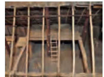
fig. 5.15 Impressie van het woongedeelte (rechts) en het stalgedeelte (boven) van het tweebeukige woonstalhuis 3 uit Bloemendaal-Groot Olmen. De kasporen zijn tegen de nokgording aangebracht, terwijl de onderkant van de kasporen bevestigd zijn aan een wandplaat. Deze wandplaat zorgt voor het langsverband in de stevig uitgevoerde wand. De zolder strekte zich oorspronkelijk wellicht over de volledige stal uit (maquette J. Matser, tentoongesteld in Archeologiemuseum Huis van Hilde; foto J. de Koning).
