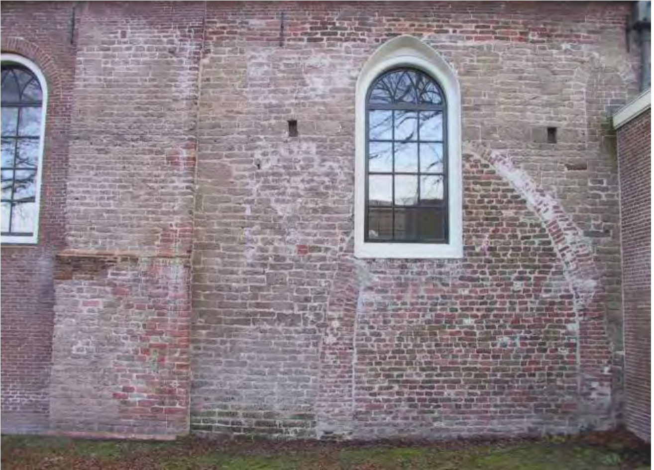
5.14 Noordmuur tufstenen schip met dichtgezette doorgang naar Brederodekapel.
