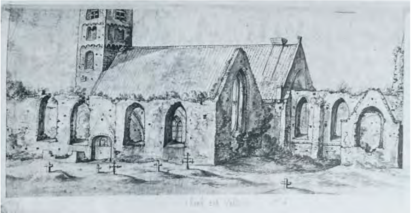
5.18 De St.-Engelmunduskerk te Velsen-Zuid. Tekening van A. Willaerts (1577-1664) uit circa 1640. Boven de ingang van de zijbeuk (links) is de dakafdruck en het timpaan zichtbaar. Prent Noord-Hollands Archief.
