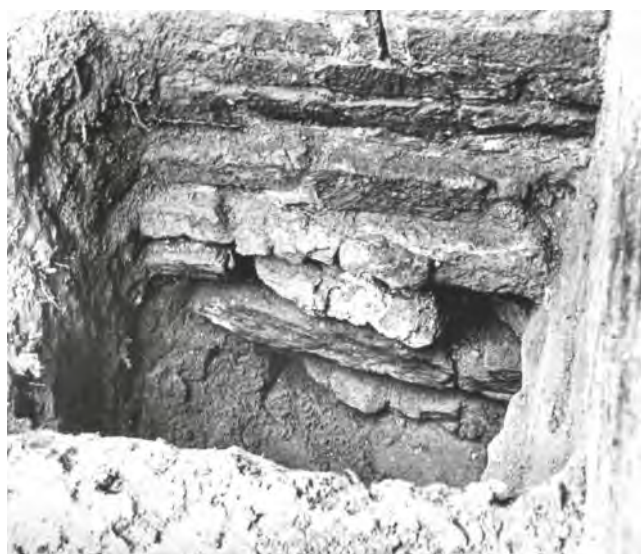
5.28 Fundering toren. Westmuur in noordoosthoek. Bovenaan vier lagen tufsteen, eronder vier lagen grauwacke natuursteen. Foto Gemeente Velsen 1952.
